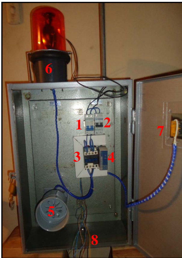
Figura 26. Componentes del Dispositivo de Alerta ante Inundaciones Las Adjuntas.
