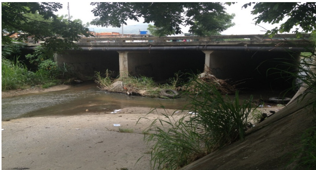
Figura N° 5 Situación actual del puente Av. Universidad
