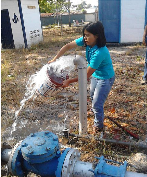
Figura 20. Medición del nivel dinámico y caudal del pozo Morro I, Coordenadas UTM 613566E; 1129798N. Elevación 462 msnm. Zona Centro, Municipio San Diego, Estado Carabobo. Fecha 15/03/2018. Fuente: Los Autores
