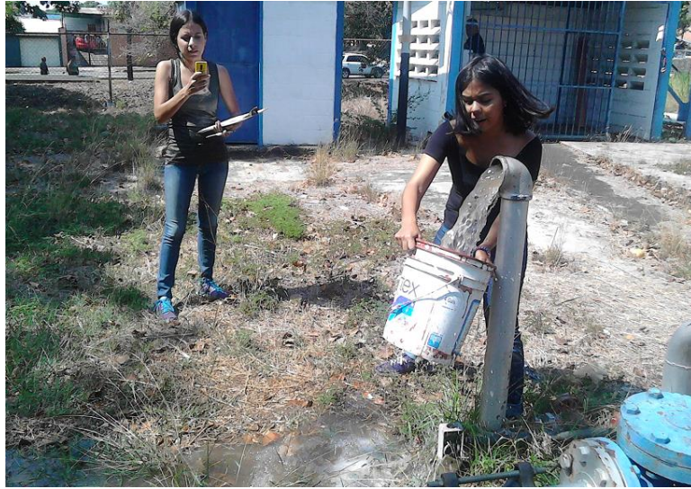
Figura 55. Medición del nivel dinámico y caudal del pozo Morro I, Coordenadas UTM 613566E; 1129798N. Elevación 462 msnm. Zona Centro, Municipio San Diego, Estado Carabobo. Fecha 05/04/2018. Fuente: Los Autores
