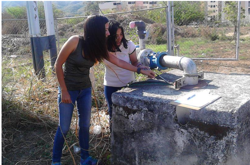
Figura 54. Medición del nivel estático del pozo YUMA en compañía del Técnico Elisaul García. Coordenadas UTM 614197 E; 1130251 N. elevación 463 m.s.n.m. Zona Centro, Municipio San Diego, Estado Carabobo. Fecha 22/03/2018. Fuente: Los Autores
