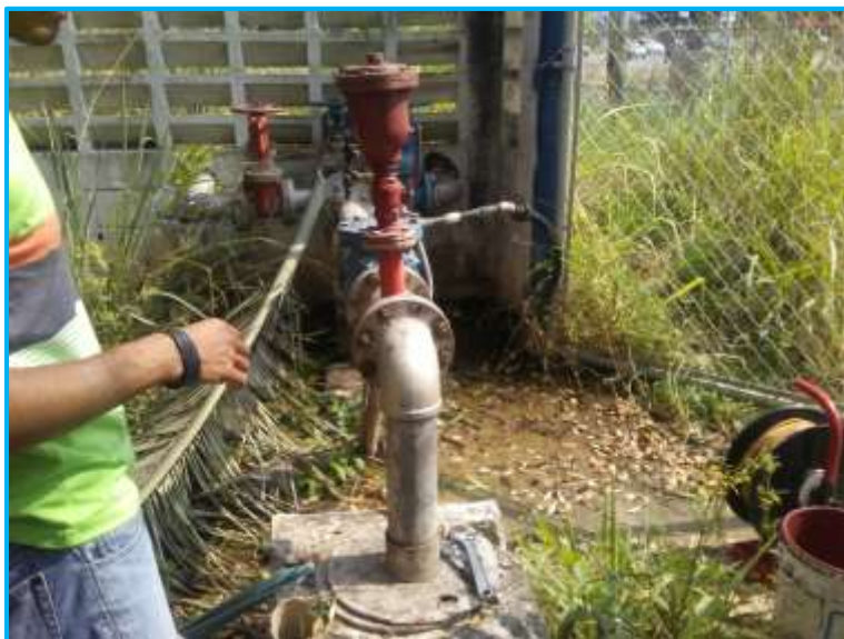
Figura 3.9 Medición del nivel freático (estático) pozo La Esmeralda, zona Centro A, municipio San Diego, estado Carabobo.
