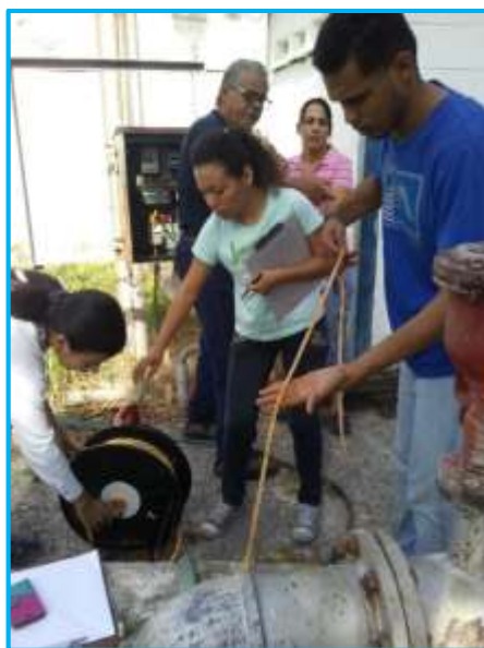
Figura 3.6 Medición del nivel estático del pozo El Morro I, zona Centro A, municipio San Diego, estado Carabobo.
