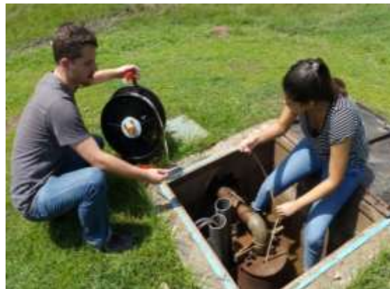
Figura 41 Medición y Lectura de niveles en el Pozo # 3 de Villas de San Diego Country club. Coordenadas 615.974,25 E; 1.137.460,67 N, elevación 495 m.s.n.m Municipio San Diego, Estado Carabobo. Fecha: 24/10/2016. Fuente: Los Autores.
