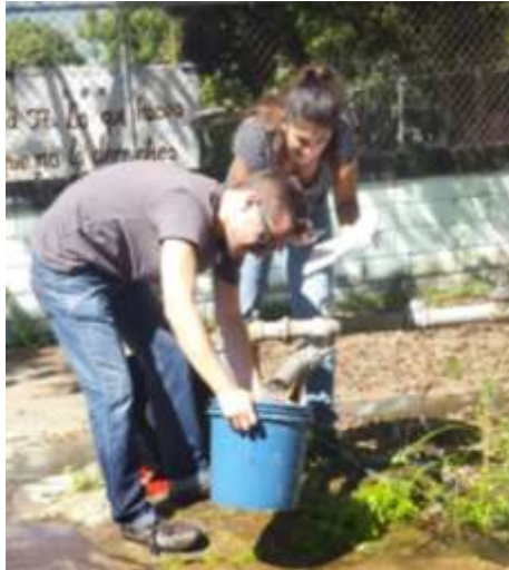
Figura 19 Llenado del tobo para la prueba de caudal variable, Pozo # 6 de A.C conjunto residencial El Tulipán. Coordenadas 613.536,88E; 1.134.540,80 N, elevación 480 m.s.n.m, Municipio San Diego, Estado Carabobo. Fecha: 24/10/2016. Fuente: Los Autores.
