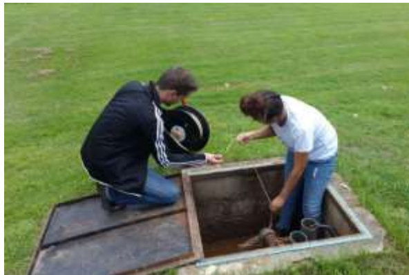
Figura 39 Medición y Lectura de niveles en el Pozo # 3 de Villas de San Diego Country club. Coordenadas 615.974,25 E; 1.137.460,67 N, elevación 495 m.s.n.m Municipio San Diego, Estado Carabobo. Fecha: 26/09/2016. Fuente: Los Autores.
