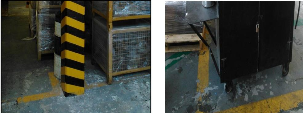
**Figura 6.** Demarcación de áreas ausentes o deterioradas
