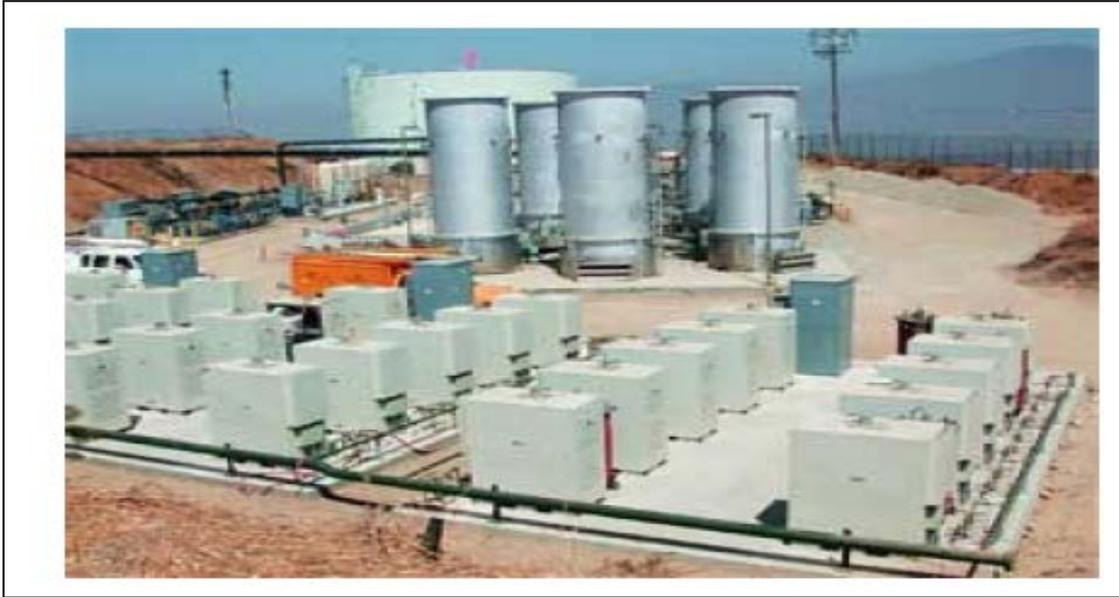
**Figura 5.2.** Relleno sanitario con recuperación de biogás utilizando microturbinas
