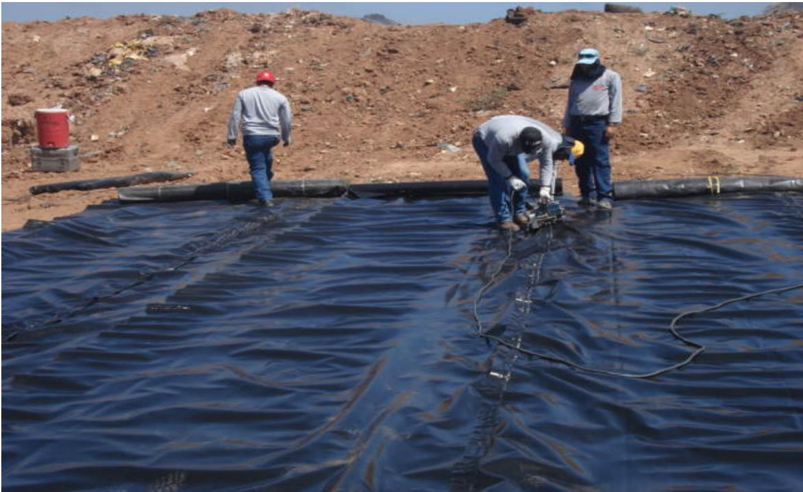
**Figura E.3.** Colocación de geomembrana en fosa del relleno sanitario de “La Paragüita”.
