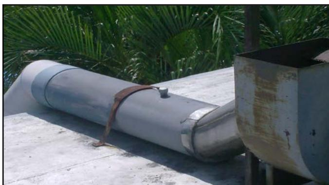
**Figura 3.3. Punto de toma de muestras gaseosas instalado en el ducto de la campana del LQO**
