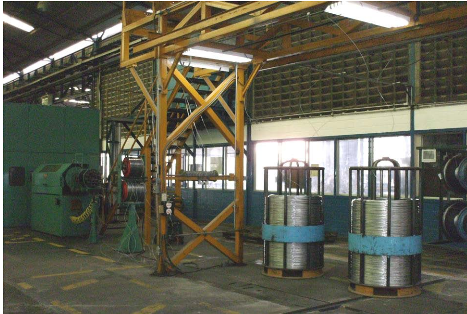
FIGURA N°2.9: Foto de la Máquina Cableadora Tipo Buncher 1600 con detalle de las cestas, el sistema tensor y las hileras. (Fuente: L. Alvarez, 2007)
