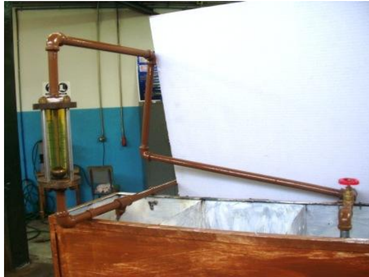
Figura 4-27.- Identificación de las tuberías, parte lateral del Banco de Ensayos. Fuente: Propia.
