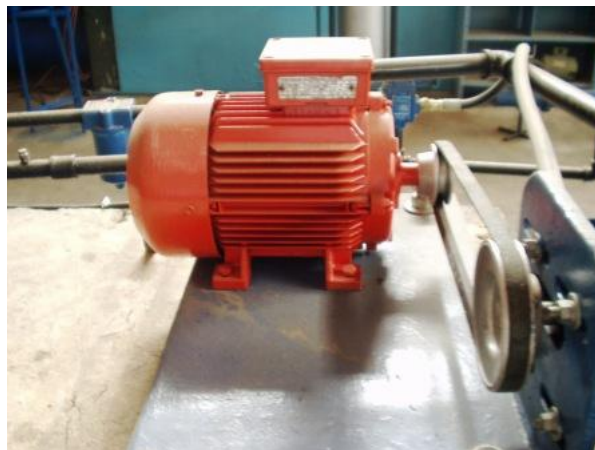
Figura 4-4.- Fijación de la bomba y el motor.
