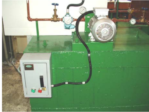
Figura 4-25.- Sistema eléctrico Interruptores – Motor. Fuente: Propia.
