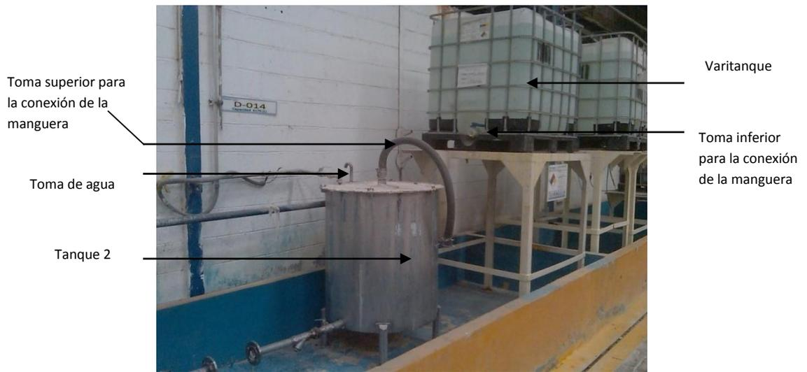
Figura 1.4. Equipos involucrados en la dilución de la soda cáustica al 10%
