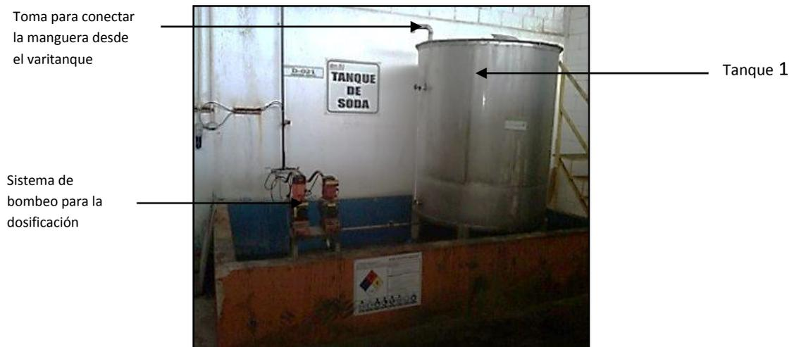
Figura 1.3 Tanque para el suministro de soda cáustica al 50%
