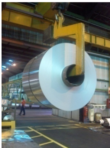
Figura 4.7.- Gancho puente grúa 25TON Nave “A”
