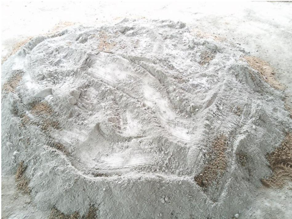
**Figura 9.** Incorporación del cemento
