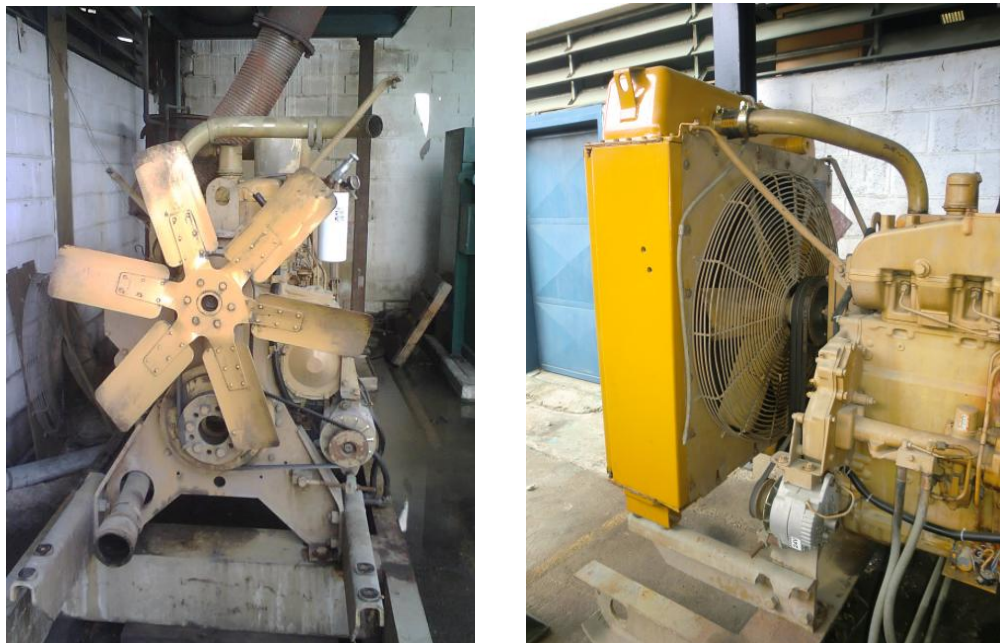
Figura 19: Mantenimiento a PLE-01.
