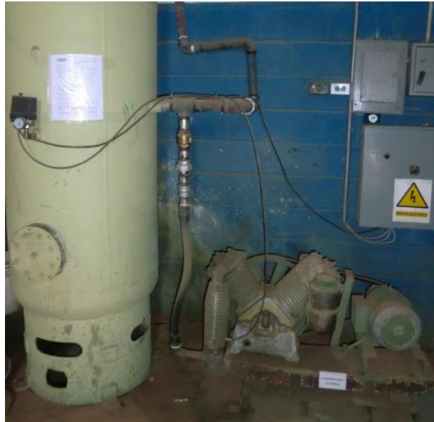
Figura 23: Instalación de COM-04.
