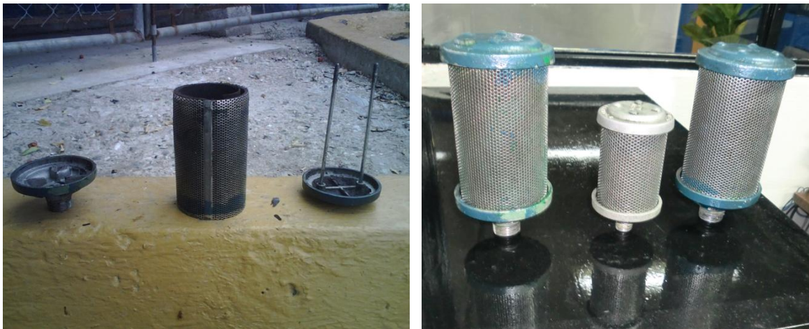
Figura 21: Mantenimiento a COR-01.
