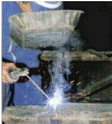
Figura 2.4. Proceso de soldadura por Arco eléctrico.
