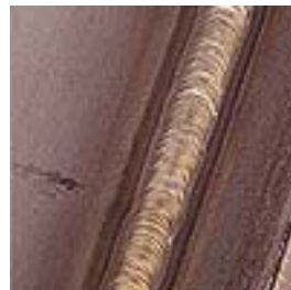
Fig. 12. Cordón de soldadura
