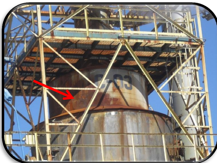
Figura 4.2 Parte superior de la torre C-03.
