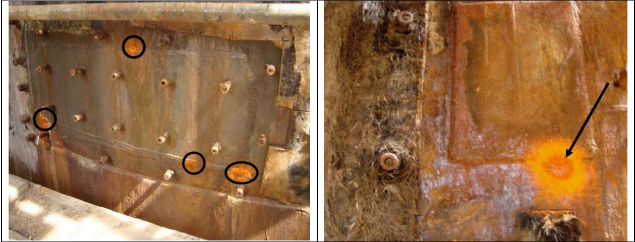
Anexo 5. Imagen torre absorción C-03 inspección visual antes de medición de espesores, ubicadas en el lado nor-oeste de la carcaza de la torre.
