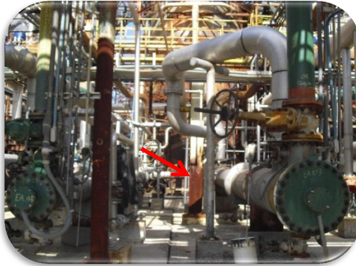
Figura 4.4 Vista de la parte posterior de la torre C-03
