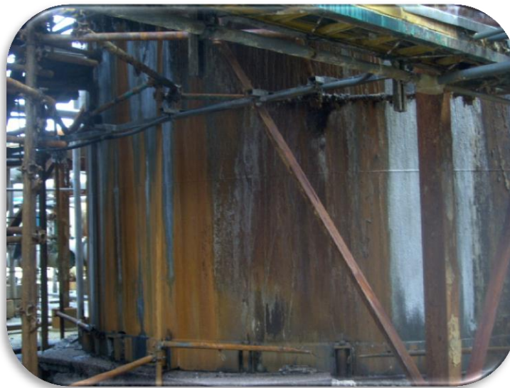
Figura 4.7 Vista lateral del faldón.
