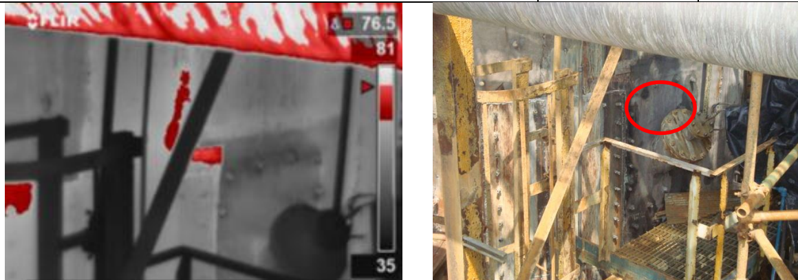
Figura 4.13 Imagen de la Torre de Absorción C-03 ubicada en la pared cilíndrica lado Noreste.
