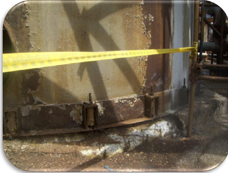
Figura 4.8 Sistema de Anclajes.
