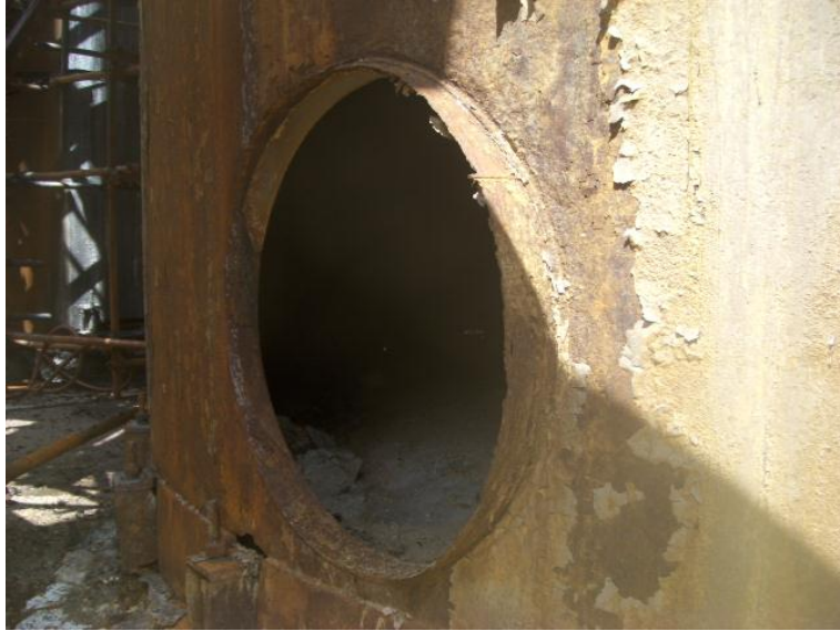
Anexo 25. Vista lateral del manhole (boca de visita).
