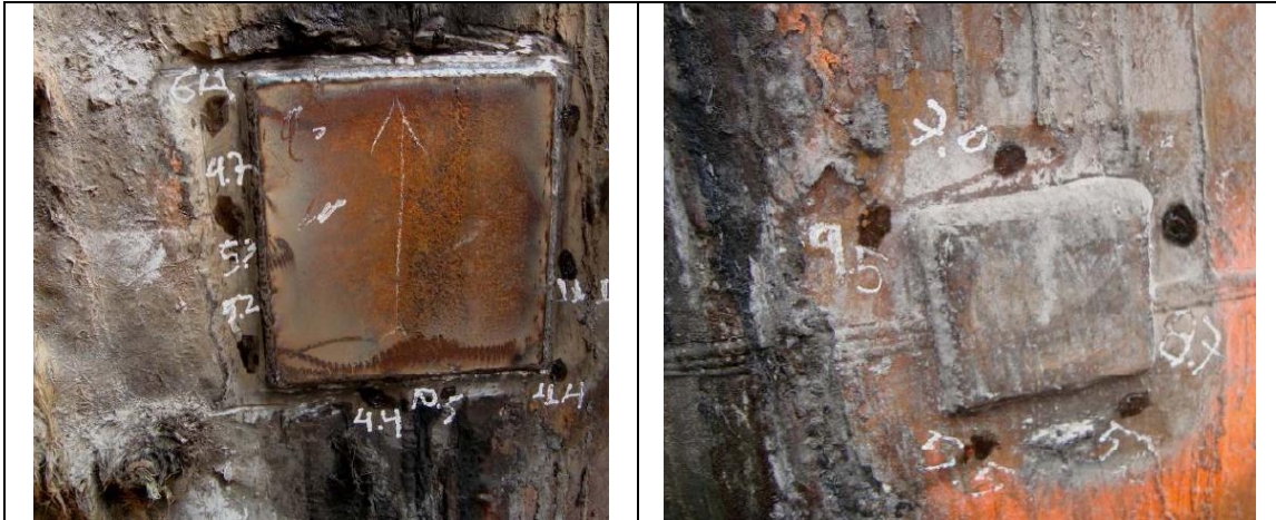
Figura 4.29 Imagen torre absorción C-03 de medición de espesores mostrando valores obtenidos.
