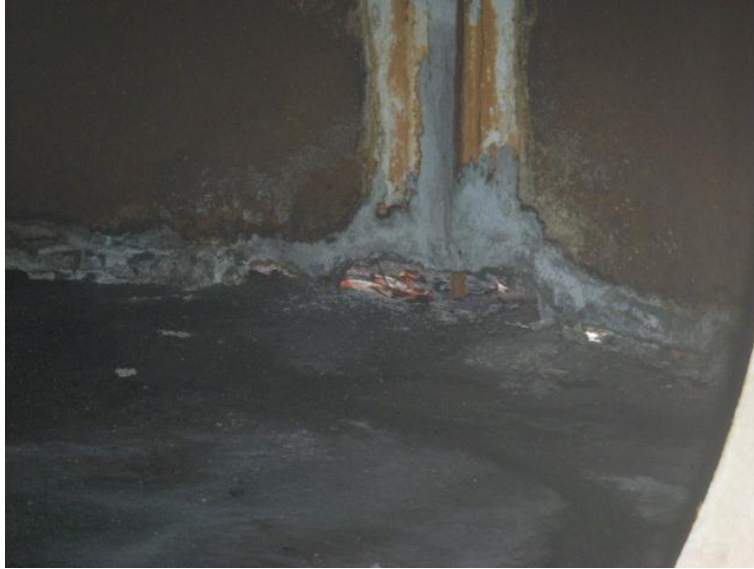
Anexo 27. Parte interior del faldón.
