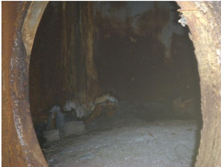
Anexo 26. Acceso a la parte interior del faldón.
