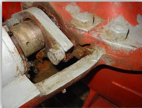
**Figura 2.8.** Corrosión galvánica en la camisa de un eje y en el prensa estopa de una bomba.
