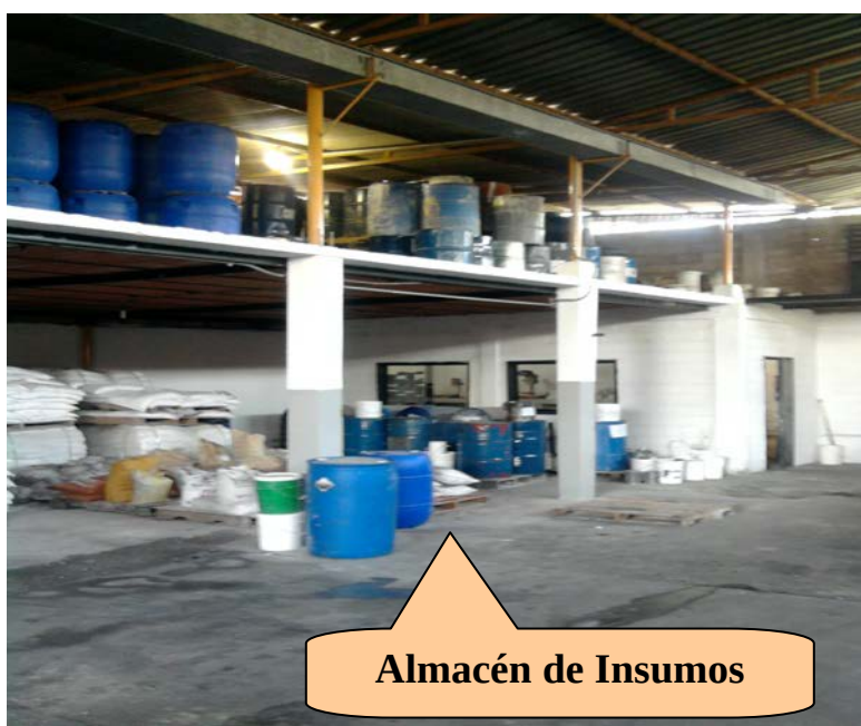
Figura IV.5. Almacén de Materiales e insumos.
