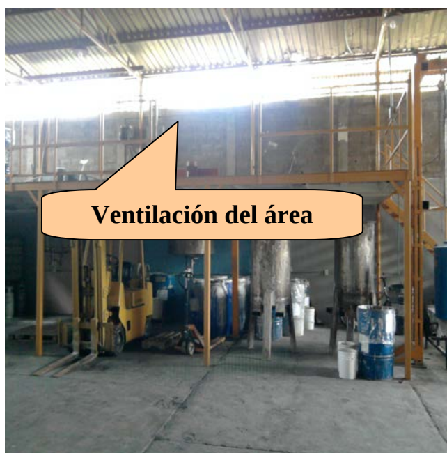
Imagen IV.9. Ventilación del área.
