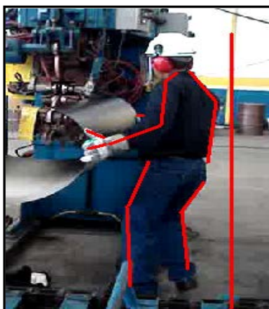
Figura 11: Alimentación manual y activación de la máquina soldadora.
