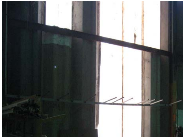
Figura N°14. Iluminación del área
