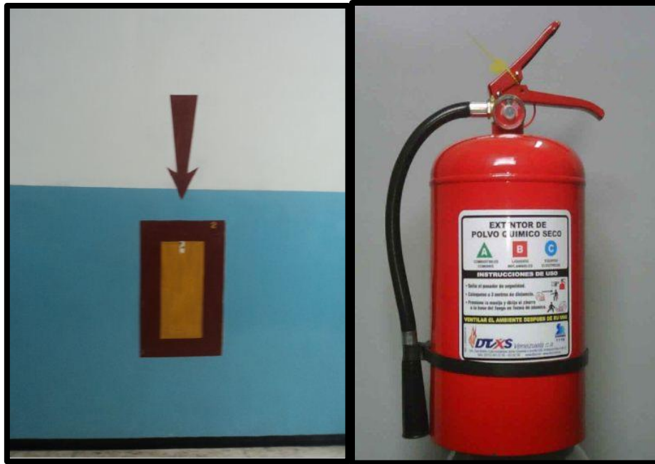
Figura 5-M Deficiencia en Extintores, propuesta de extintor
