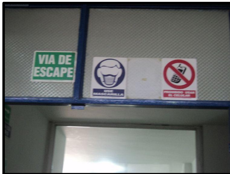
Figura 10-M Ausencia de señales de advertencia
