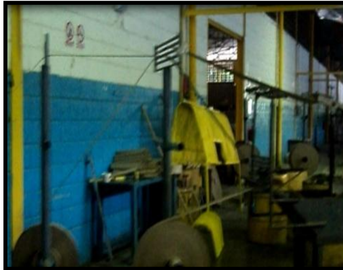
Figura 4.5 Riesgo eléctrico y obstáculos en el camino, DPP
