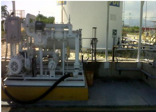
**Figura VI.3. Filtro de Recepción junto a espacio disponible para mecanismo recolector de muestras.**
