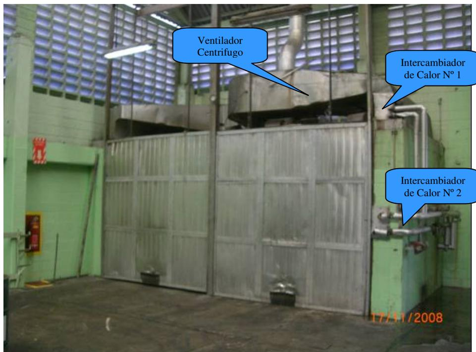
Figura 1.1 Cámara de Circulación de Aire Caliente
