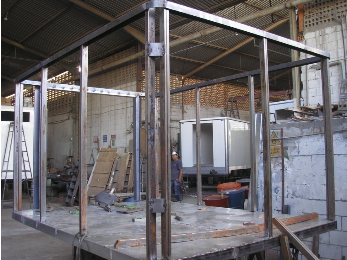
Figura Nro. 8, Etapa de Armado
