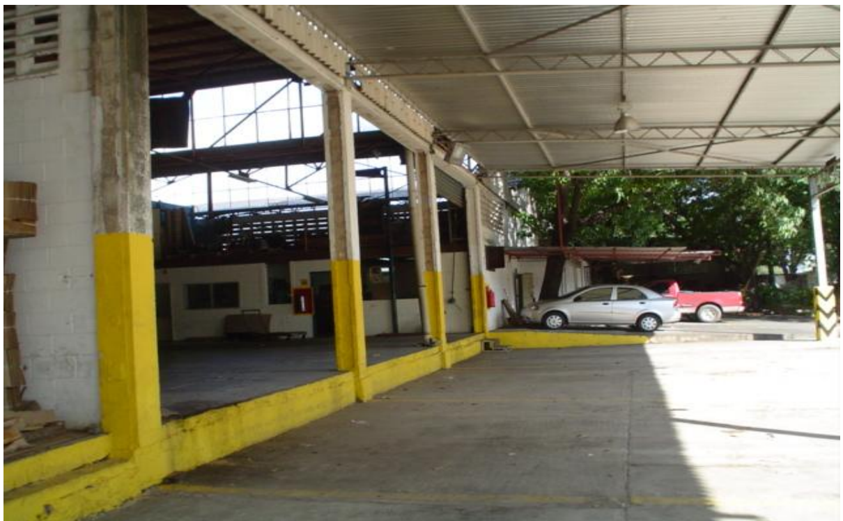
ZONA DE CARGA AREA DE CORRUGADO
