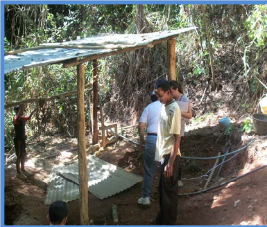
Condiciones externas del pozo N° 2
