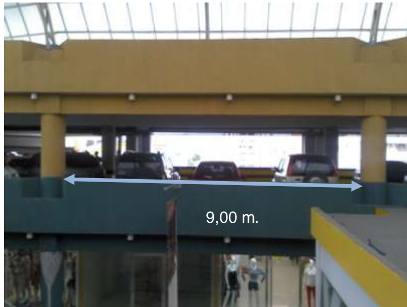
Figura 21. C.C. Galería Plaza Av. Bolívar Oeste. Maracay (Luz entre Pórtico). Nota: Recuperado http://maracay.conoce.com.ve/panoramio/9753
