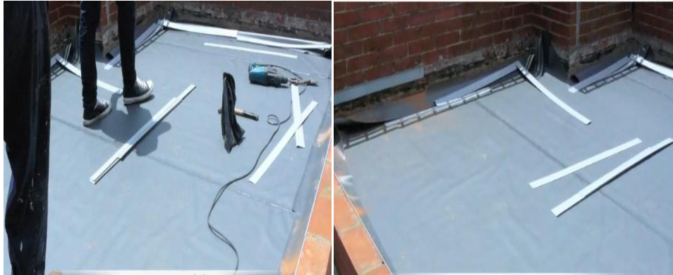
Figura 27: Imagen ilustrativa de la instalación completa de la membrana anti-raíces. Grocol.
