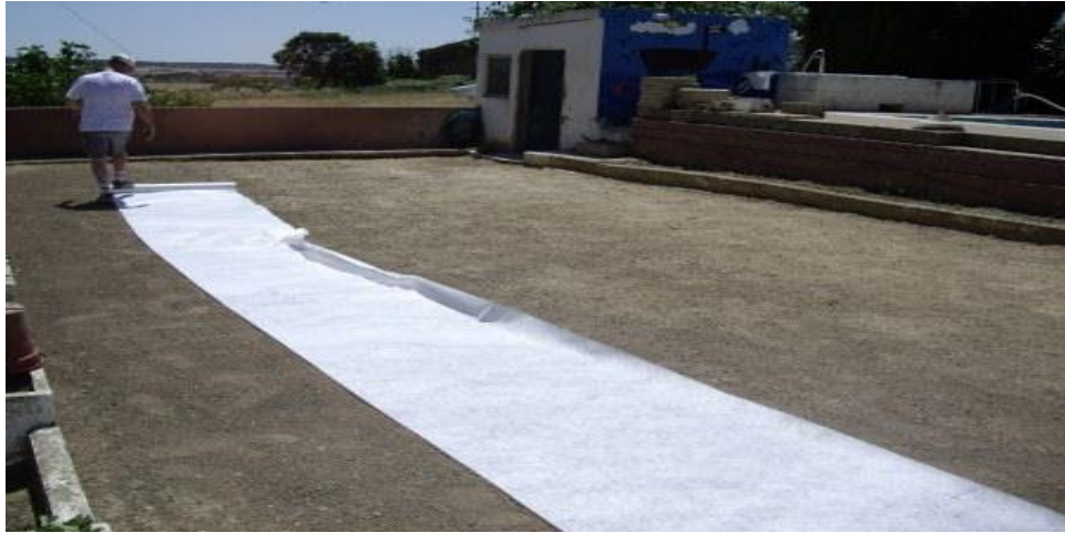
Figura 25: Imagen ilustrativa de la instalación de la primera capa de geotextil. Arelux Wordpress.com
