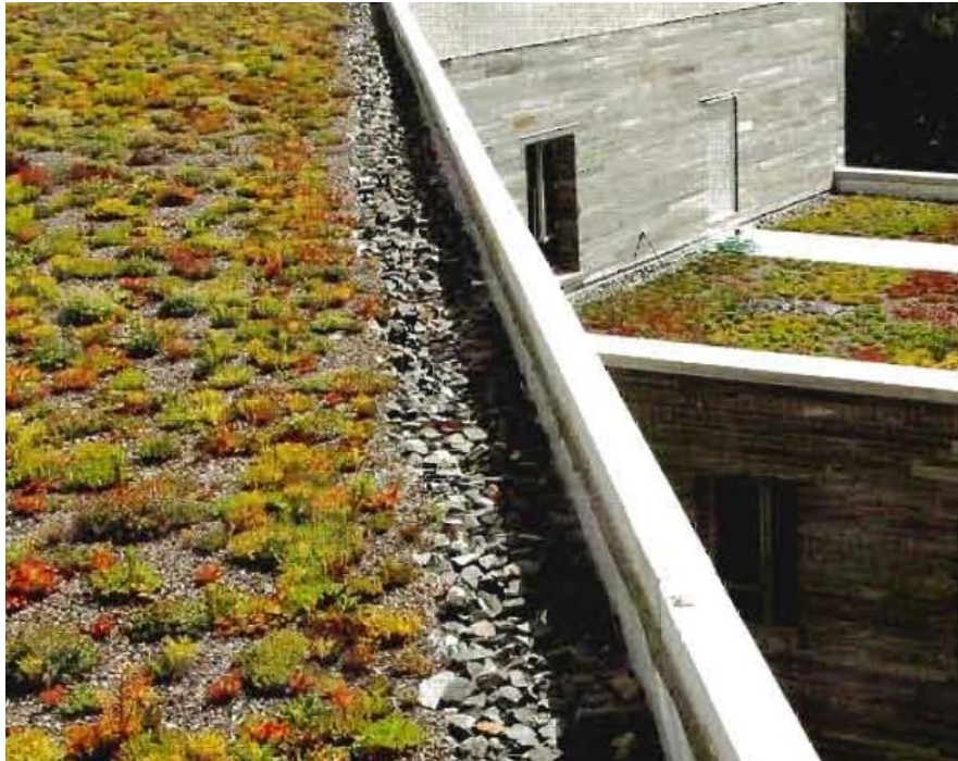
Figura 35: Imagen ilustrativa del ancho granular utilizado para drenaje de fluidos.
