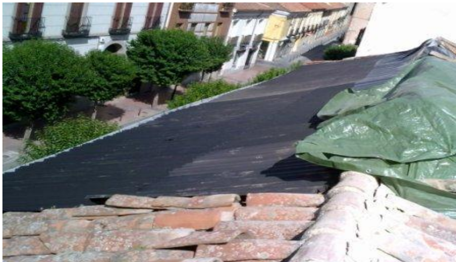
Figura 23: Imagen ilustrativa de remoción de tejas. Techotejado.com
