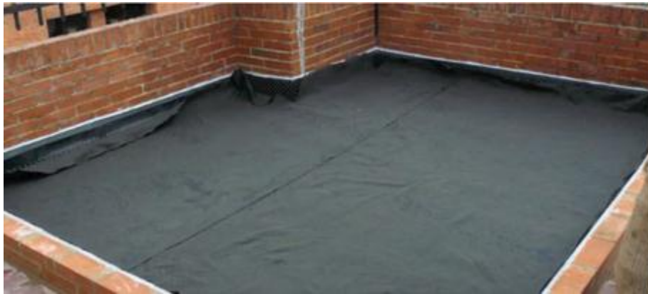
Figura 26: Imagen ilustrativa de la instalación completa de la primera capa de geotextil. Grocol.
