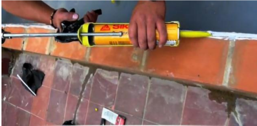
Figura 29: Imagen ilustrativa de sellado de bordes de capas con su pretil, mediante el uso de un adhesivo tixotrópico de un componente a base de poliuretano. Grocol.
