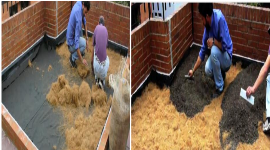
Figura 38: Imagen ilustrativa de la colocación de la capa de sustrato. Grocol.
