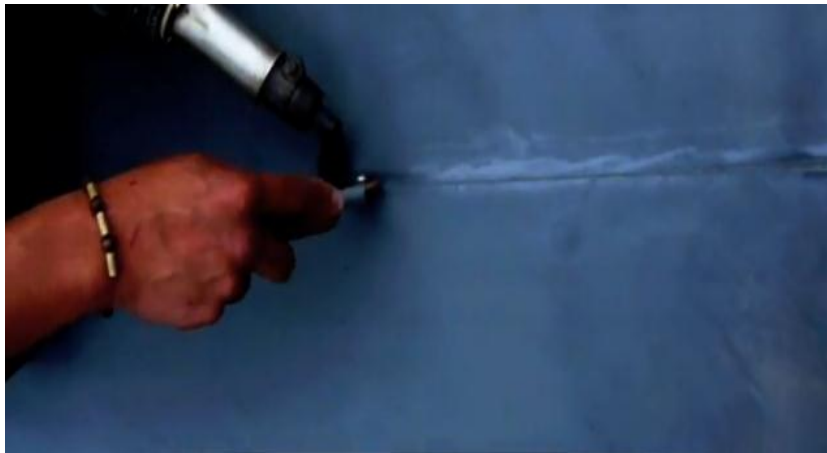
Figura 28: Imagen ilustrativa de las soldaduras termoplásticas para la realización de solapes. Grocol.
