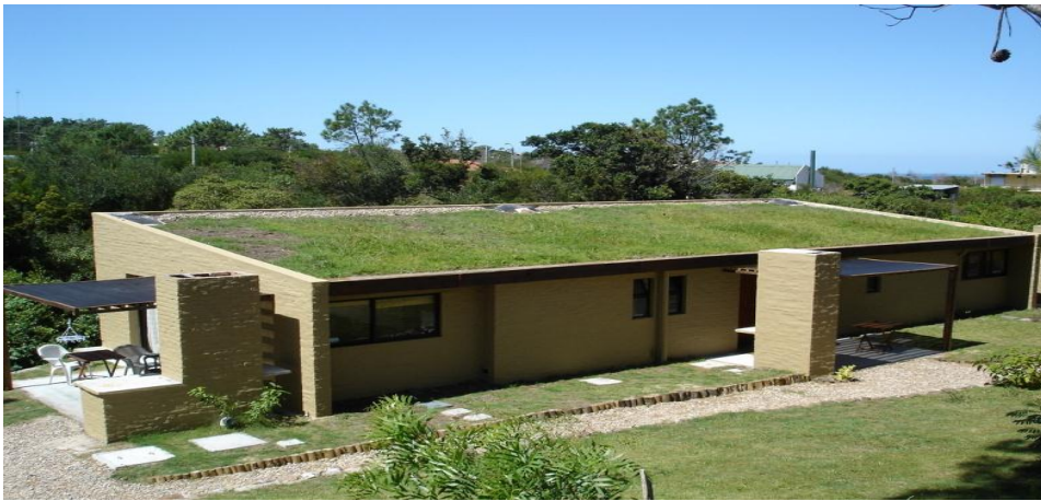
Figura 41: Imagen ilustrativa del sistema de cubiertas vegetales después de ser instalado.
