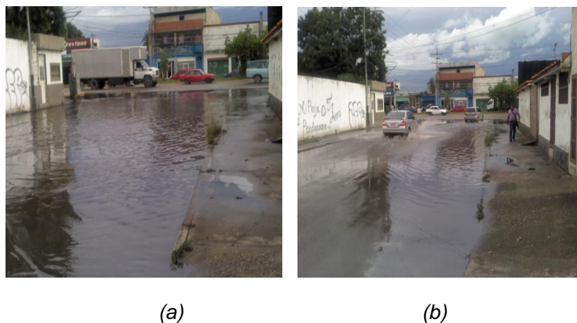
Figura 15: Sumideros ubicados en la calle Arnoldo Gabaldon sur. En la figura 15a y 15b se observa, el estado en que se encuentra inundada la vialidad después de una precipitación, ocasionando incomodidad tanto al tránsito automotor como al peatonal Gamboa, (2012).
