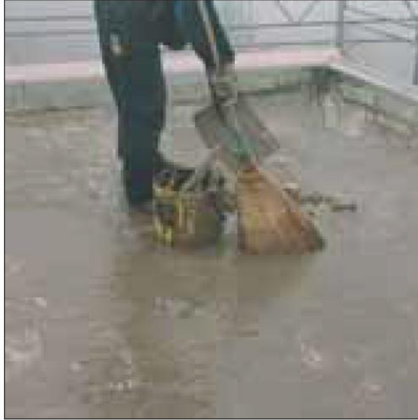
Figura 24: Imagen ilustrativa de la limpieza de las azoteas después de retirar las tejas y el sistema de impermeabilización. Sika Manual del instalador.
