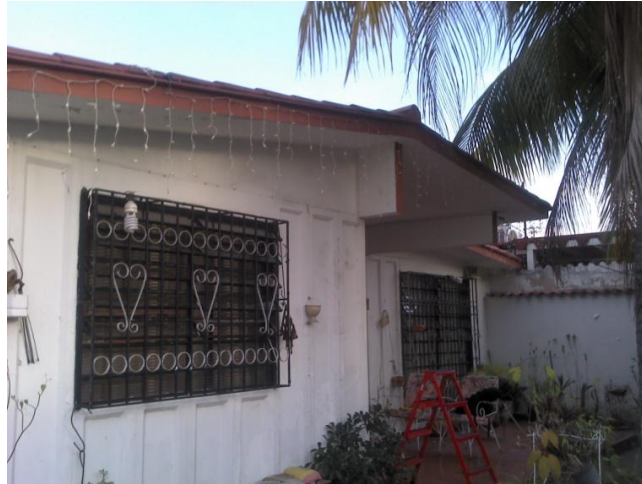
Figura 21: Modelo tipo 1 de vivienda, en la cual se determinó la inclinación de las aguas de su azotea. Gamboa. (2012).
