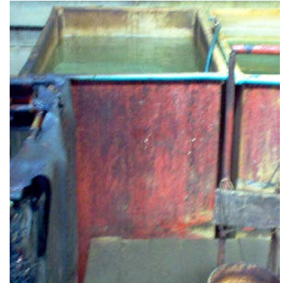
Figura 4.12 Apariencia externa de los tanques
