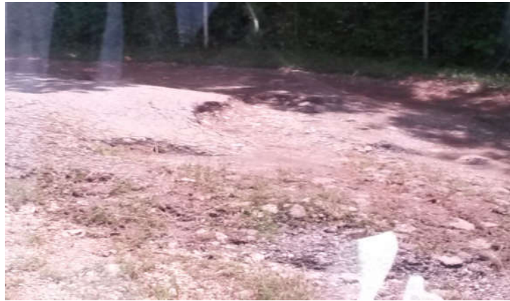
Figura N° 28: Deformaciones en el Estacionamiento de Representantes.
