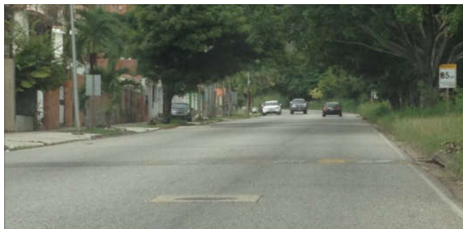
Figura N° 25: Reductores de Velocidad Ubicado en el Primer Tramo de la Calle 126.
