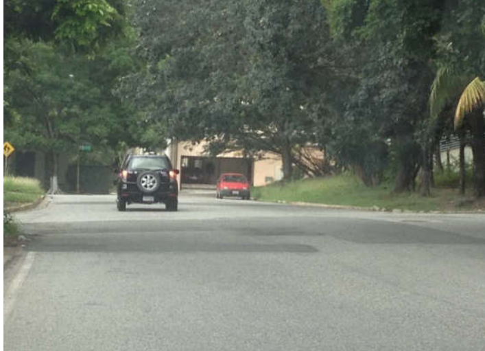
Figura N° 9. Falta de Demarcación Vial en la Avenida 88.
