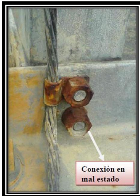
**Figura 4.15- Anclaje de sujeción del conductor de puesta a tierra oxidado**
