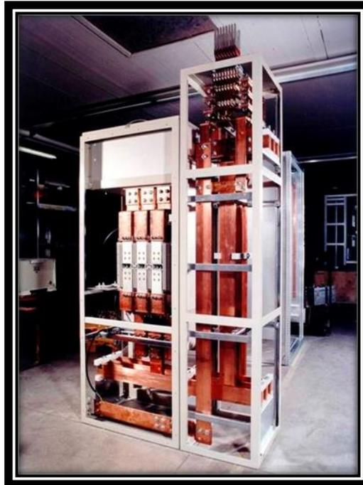
**Figura 2.10- Celda de Distribución en Baja Tensión.**
