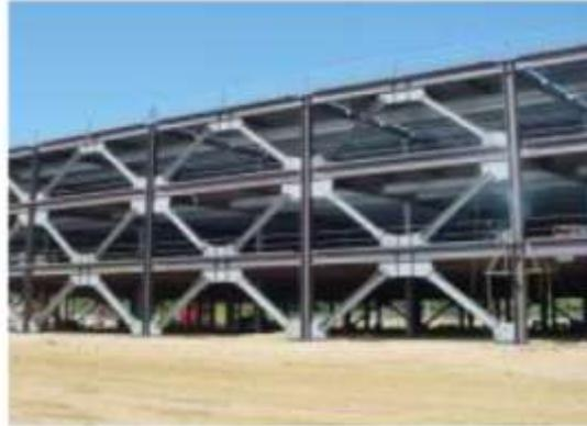
*Figura VII. Sistema de pórtico con diagonales concéntricas.*
