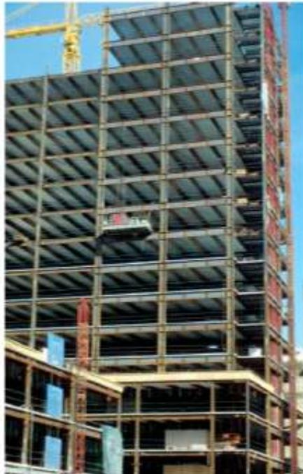
*Figura VI. Sistema de pórtico resistente a momento.*
