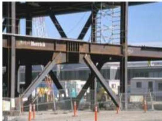
*Figura VIII. Sistema de pórtico con diagonales excéntricas.*
