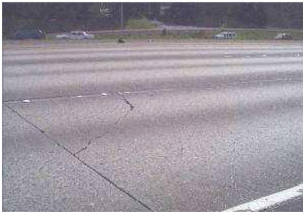
**Figura 11. Rotura de placa.**
