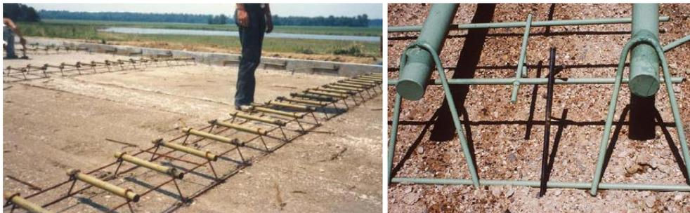
**Figura 4. Instalación de barras lisas por medio de canastas.**
