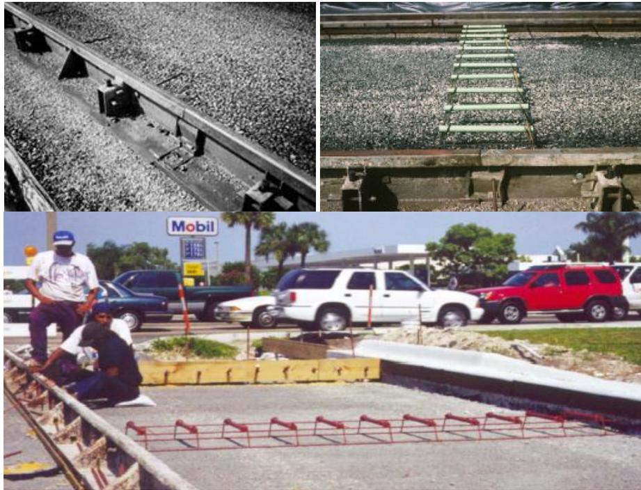
**Figura 3. Colocación de moldes metálicos.**
