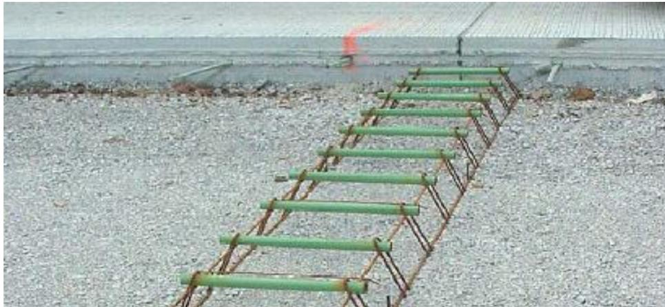
**Figura 5. Las barras deben colocarse en correspondencia con la junta transversal del pavimento vecino.**
