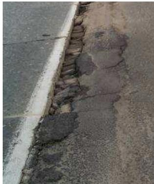
**Figura 10. Fallas por erosión.**
