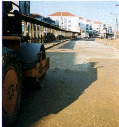
**Figura 2. Preparación del suelo de soporte.**
