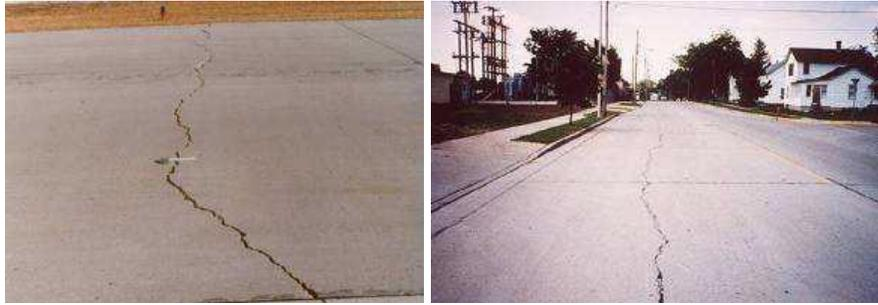
**Figura 9. Fallas transversales o longitudinales.**
