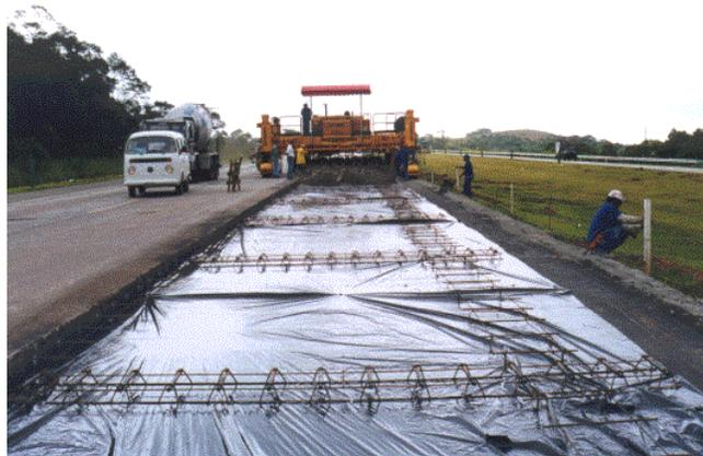
**Figura 6. Colocación de lámina impermeable.**
