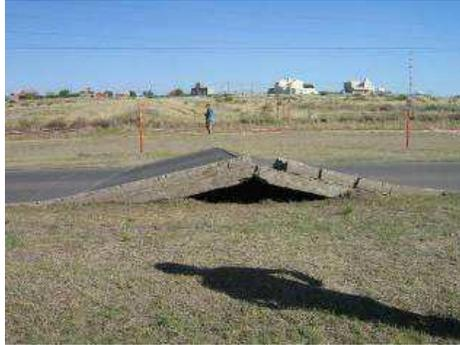
**Figura 12. Rotura de placa por levantamiento.**
