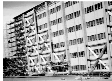
Fotografía 7 . Refuerzo con diagonales. (fuente: Evaluación, reparación y rehabilitación de estructuras de concreto)
