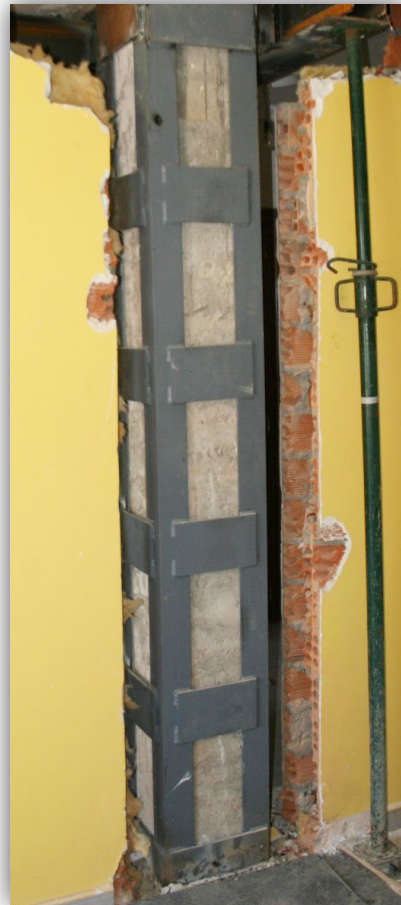
Fotografía 18 . Colocación presillas
