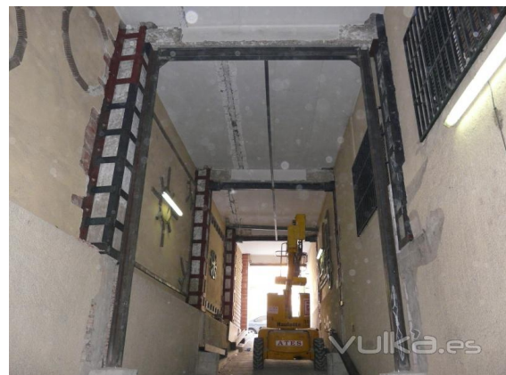
Fotografía 11 . encamisado de columnas con acero. (fuente: vulka.es)
