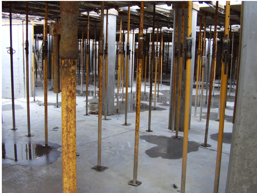
Fotografía 20. Apuntalamiento de viga (fuente: narcizobarros.com)
