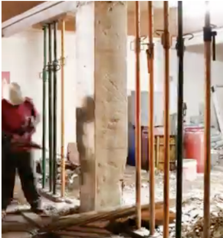
Fotografía 17 . Apuntalamiento columna. (Fuente:eurolosa.com)
