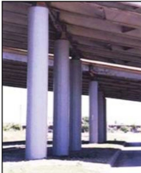
Fotografía 13 .columna encamisada de concreto. (fuente: http://www.quakewrap.com )
