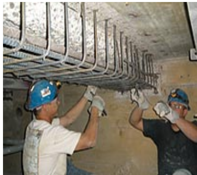
Fotografía 5 . Recreido de viga. (fuente: http://kcwardco.com )
