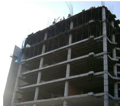
Fotografía 1. Estructura aporticada. (Fuente: http://www.civil.cicloides.com )
