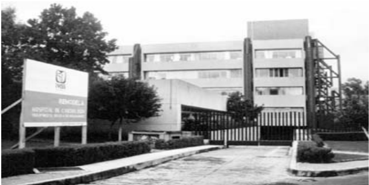
Fotografía 6. Hospital de Cardiología del Instituto Mexicano del Seguro Social que fue reforzado usando pórticos contrafuertes (fuente: Evaluación, reparación y rehabilitación de estructuras de concreto)
