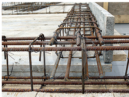
Fotografía 2. Armadura acero. (Fuente: http://es.dreamstime.com )
