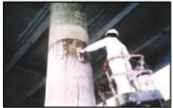
Fotografía 14 .rehabilitación. (fuente: http://www.quakewrap.com )
