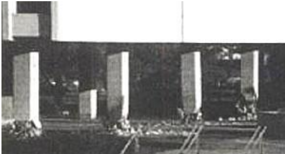
Figura 9: Columnas en nivel inferior.
