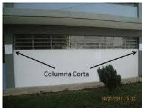
Figura 20: Efecto de columna corta.
