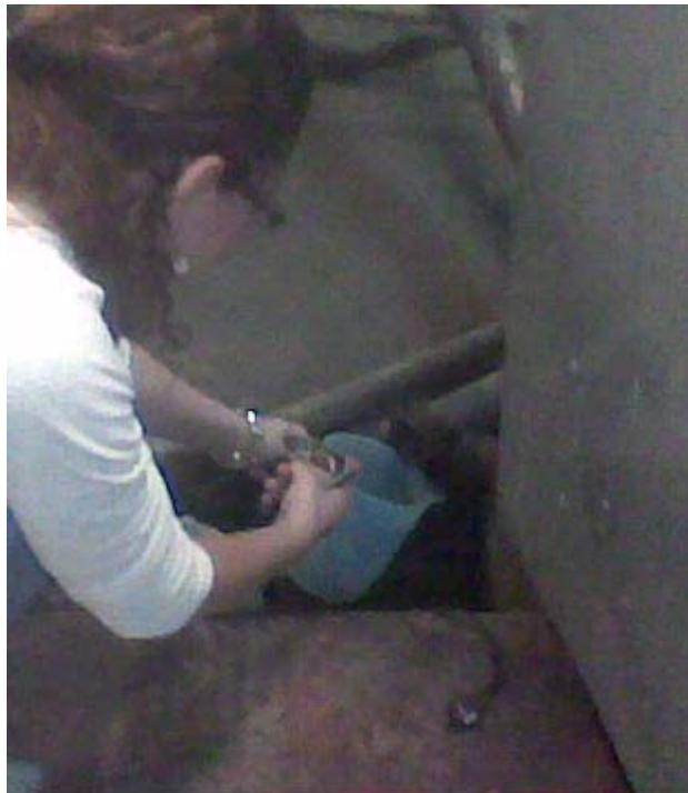
Figura C.4. Llenado de tobo para determinación de caudal de los tanques de enjuague del proceso de galvanizado
