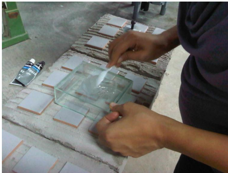
Removiendo adhesivo epoxico para la colocación de pieza
