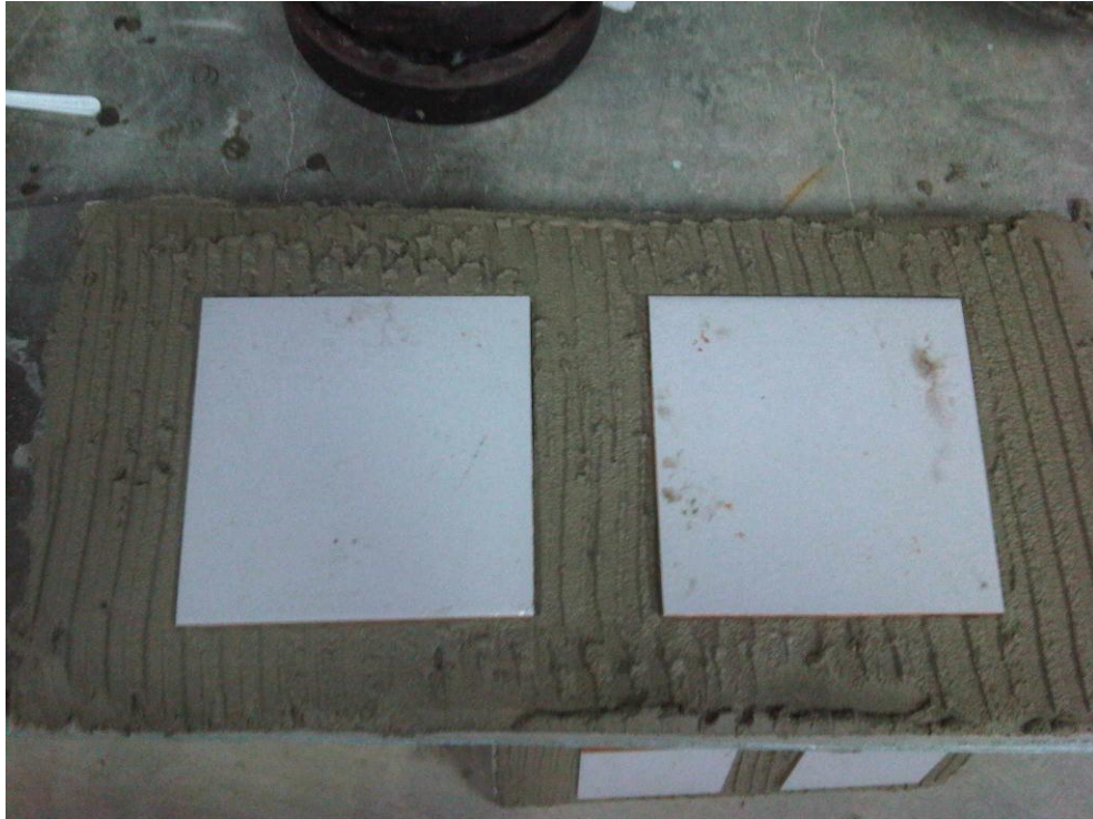
Colocación de probetas luego de aplicado el mortero adhesivo PR
