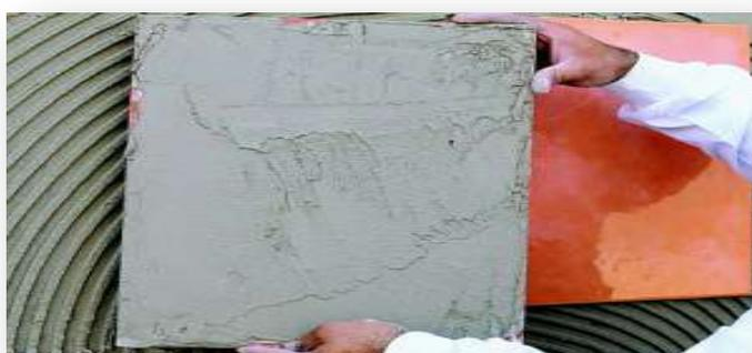
*Figura 10. Aplicación del mortero adhesivo en toda la superficie de la baldosa. Nota. Datos tomados de [http://www.construmatica.com/construpedia/Morteros\\_Cola](http://www.construmatica.com/construpedia/Morteros_Cola)*
