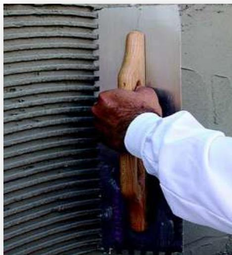
*Figura 11. Adhesivo "peinado" con la llana dentada. Nota. Datos tomados de [http://www.construmatica.com/construpedia/Morteros\\_Cola](http://www.construmatica.com/construpedia/Morteros_Cola)*
