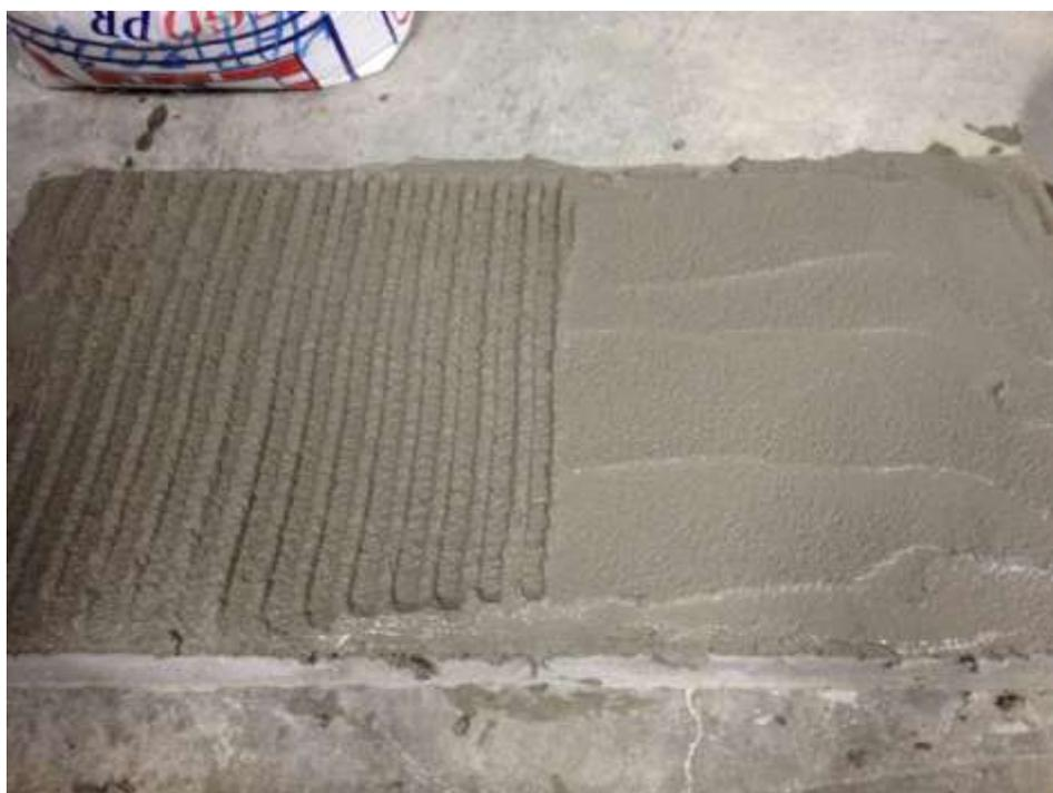
**Figura 22. Proceso de ranurar el mortero adhesivo tipo PR con el lado dentado de la llana.** *Nota.* Datos tomados de Isoldi (2012)
