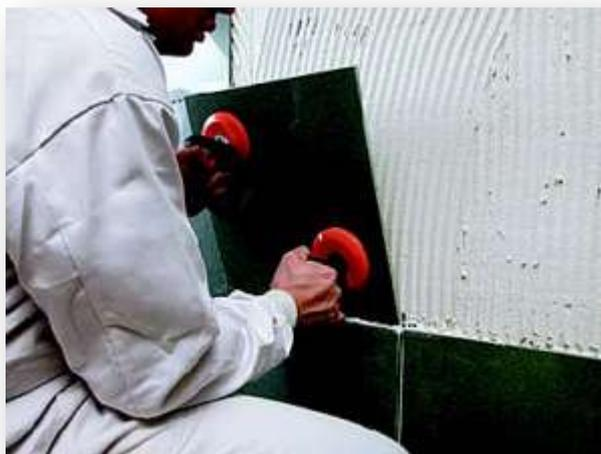
*Figura 11. **Detalle de la colocación (Capa Fina).** Nota. Datos tomados de [http://www.construmatica.com/construpedia/Morteros\\_Cola](http://www.construmatica.com/construpedia/Morteros_Cola)*
