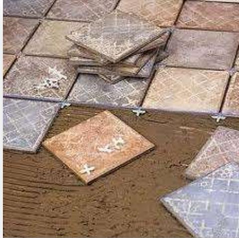
**Figura 7. Colocación de revestimientos cerámicos con morteros adhesivos.**
