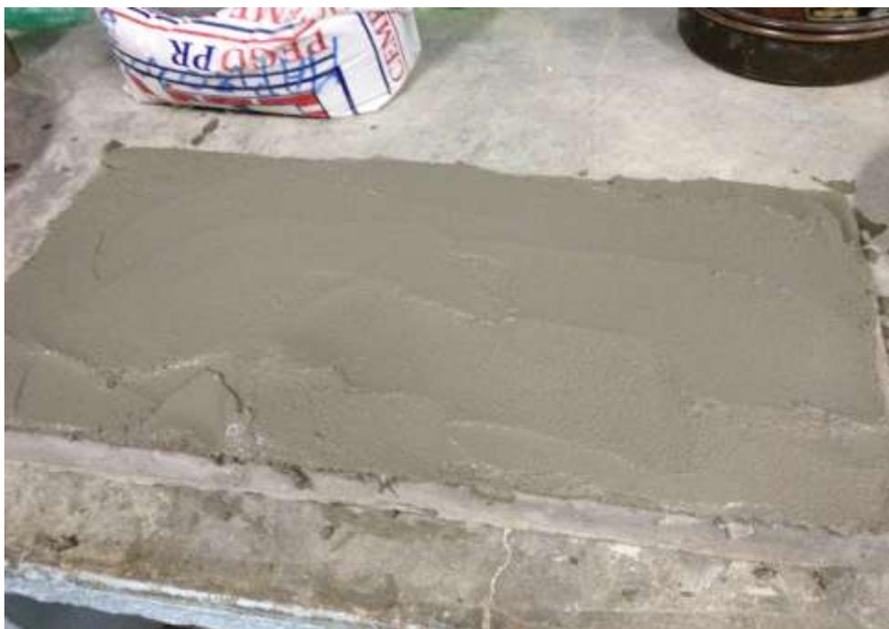
**Figura 21. Proceso de ranurar el mortero adhesivo tipo PR con el lado dentado de la llana. Nota. Datos tomados de Isoldi (2012)**
