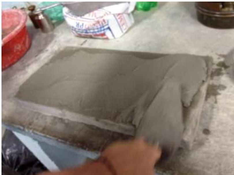
**Figura 20. Extensión del mortero adhesivo sobre la placa de concreto con el lado liso de la llana. Nota. Datos tomados de Isoldi (2012)**
