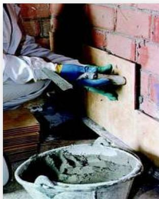
*Figura 9. Colocación de la Capa Gruesa. Nota. Datos tomados de [http://www.construmatica.com/construpedia/Morteros\\_Cola](http://www.construmatica.com/construpedia/Morteros_Cola)*
