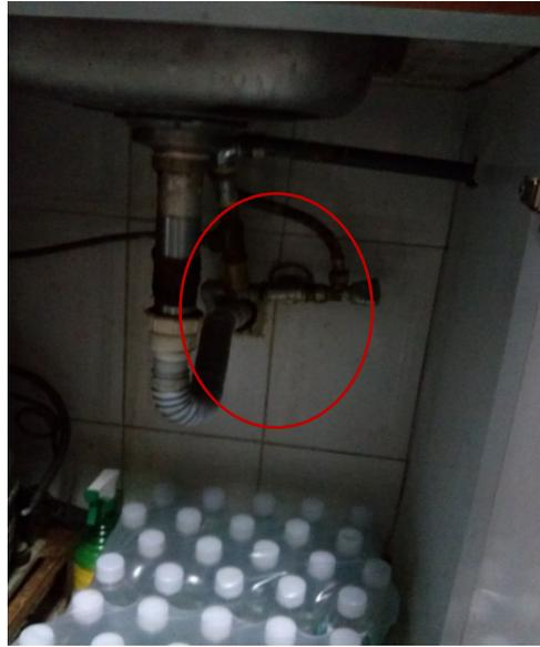
*Figura 4.11. Conexiones inadecuadas.* Nota. Fotos tomadas en sitio por Castillo y López (2016).
