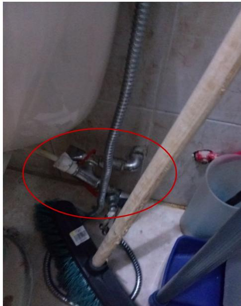
*Figura 4.12. Conexiones inadecuadas.* Nota. Fotos tomadas en sitio por Castillo y López (2016).
