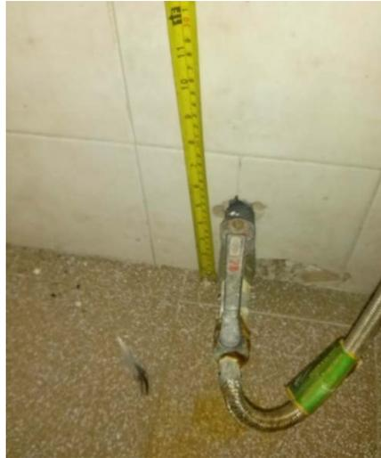
*Figura 4.7. Llaves de arresto en condiciones de deterioro.* Nota. Fotos tomadas en sitio por Castillo y López (2016).
