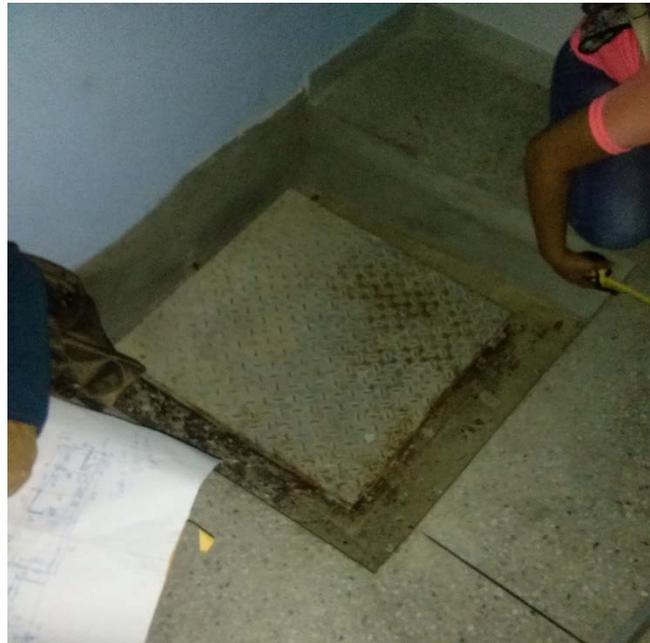
*Figura 4.3. Bocas de visita de los tanques subterráneos con difícil acceso. Nota. Fotos tomadas en sitio por Castillo y López (2016).*
