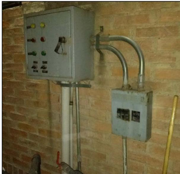
Figura 4.29. Tablero de control del sistema de bombeo ubicado en el cuarto de bombas de Cruz Roja Seccional Carabobo-Valencia. Nota. Castillo y López.
