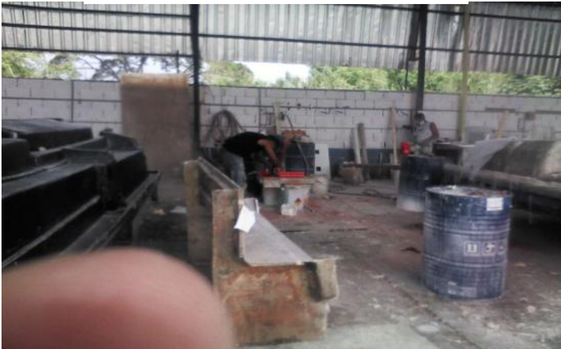
Fotografía N° 2. Taller de Elaboración de Lanchas, donde se observa la falta de implementos de seguridad.
