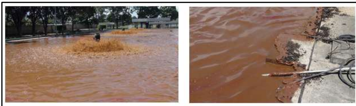
Figura 3.4. Condiciones de sobrecarga del reactor biológico operando.
