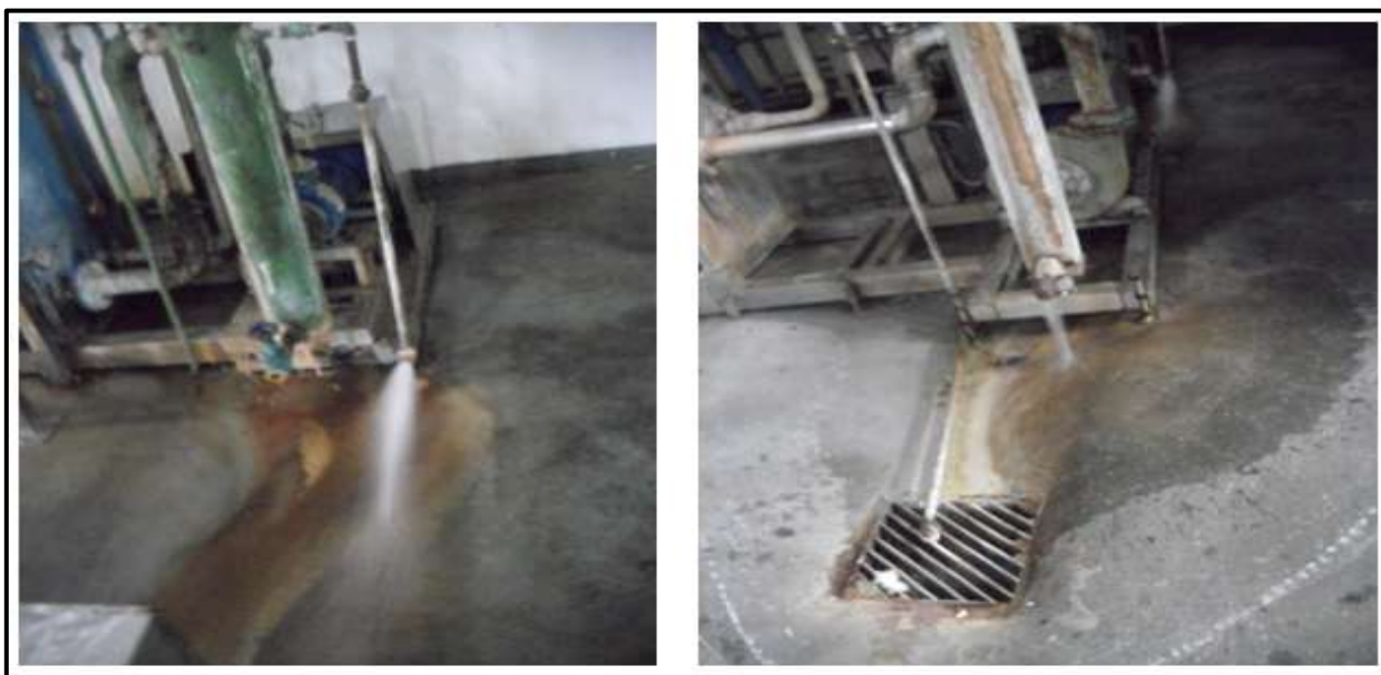
Figura 3.3. Intercambiadores de calor tubo y coraza, zona de preparación de vinagre y salsas negras.
