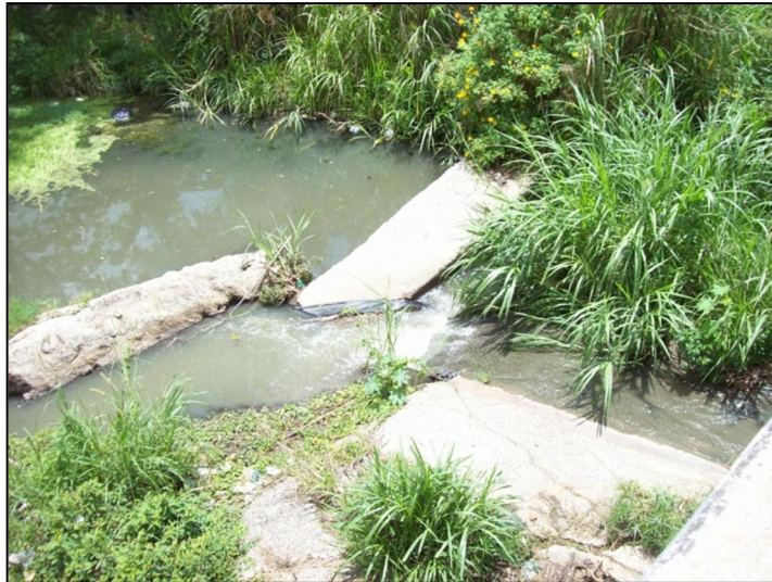
Figura 11. Vista aguas abajo del cajón hidráulico existente.
