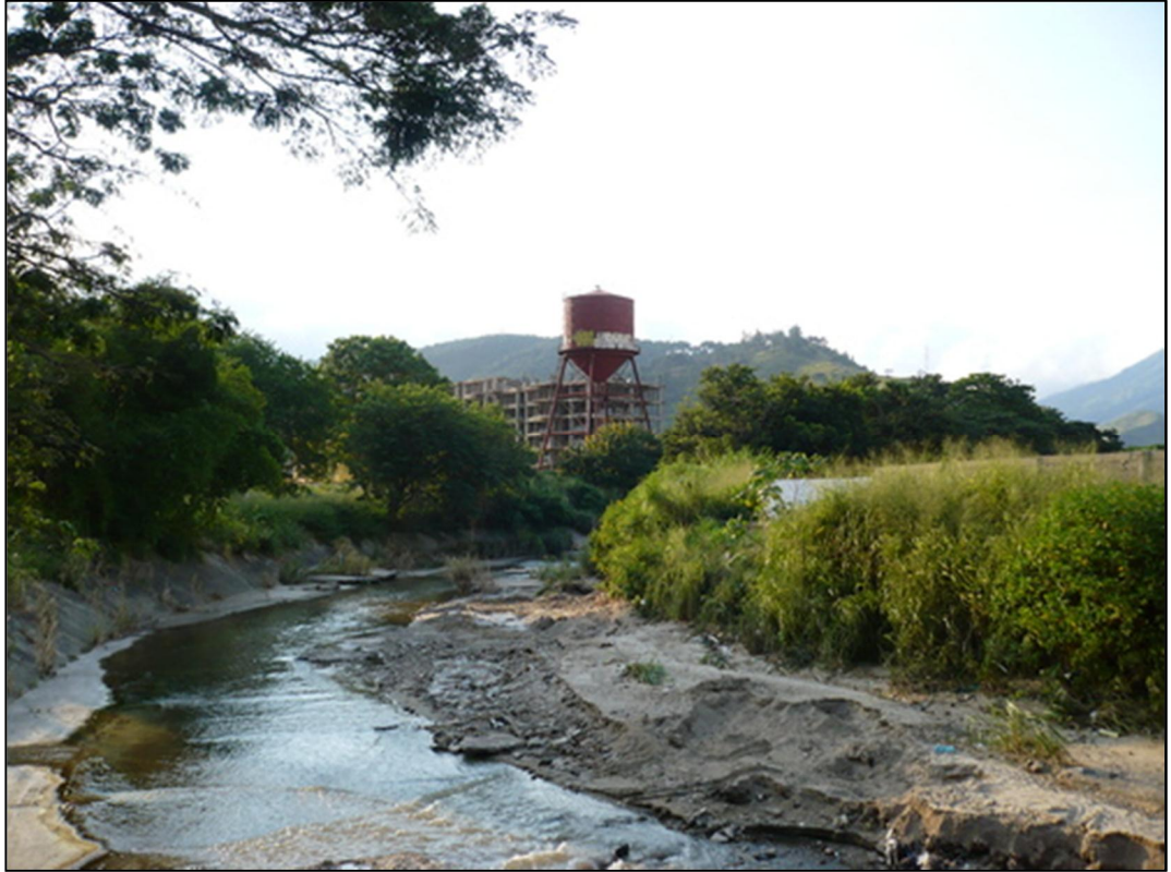
Canalización del río Retobo, aguas abajo del tramo en estudio.
