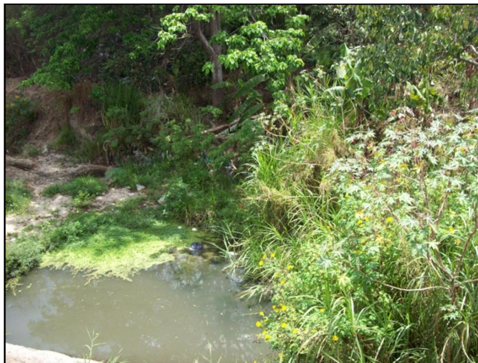
Figura 8. Vista aguas abajo del cajón hidráulico existente.
