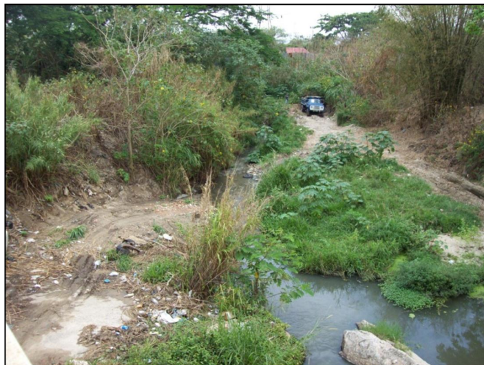
Figura 6. Vista aguas abajo del cajón hidráulico existente.
