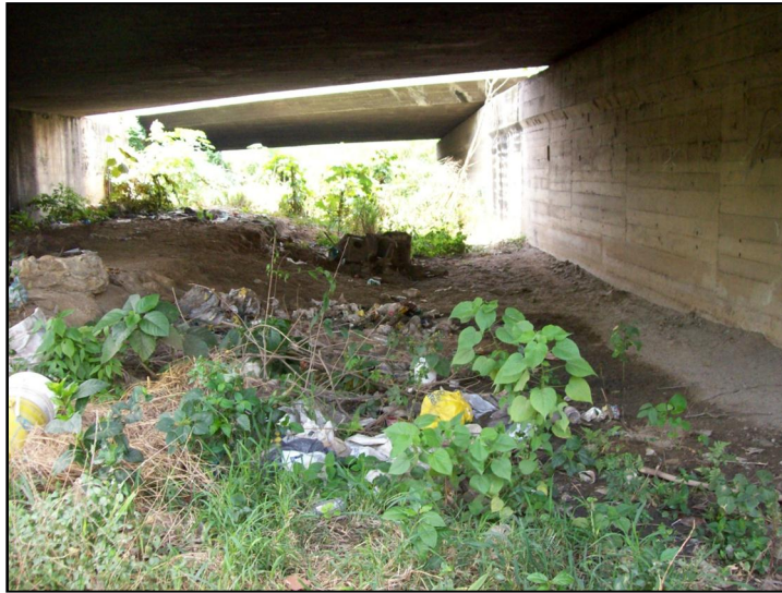
Figura 13. Vista aguas arriba del cajón hidráulico existente.
