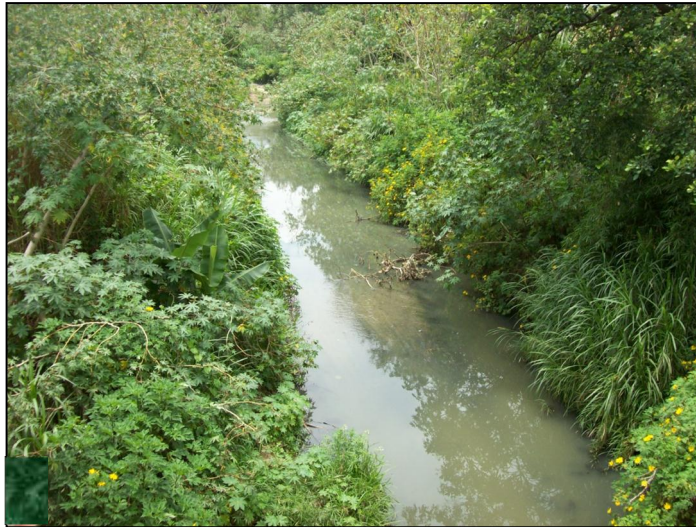
Figura 5. Vista aguas arriba del cajón hidráulico existente.
