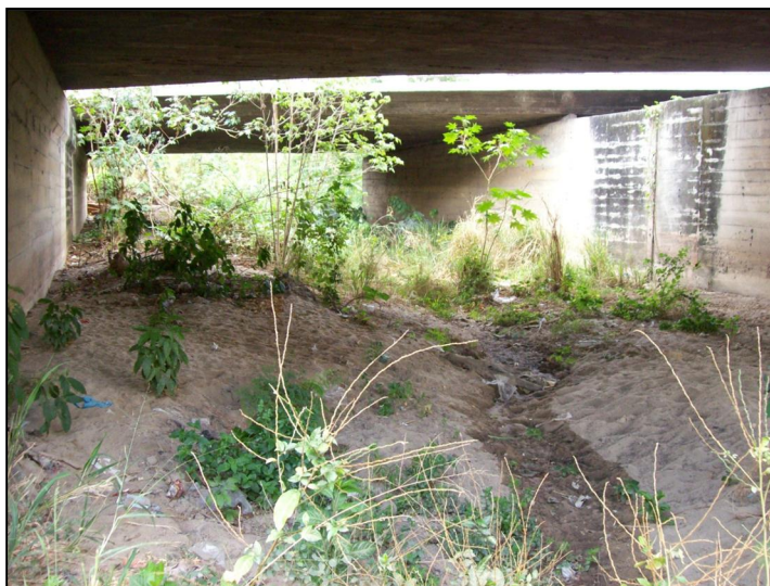
Figura 14. Vista aguas arriba del cajón hidráulico existente.
