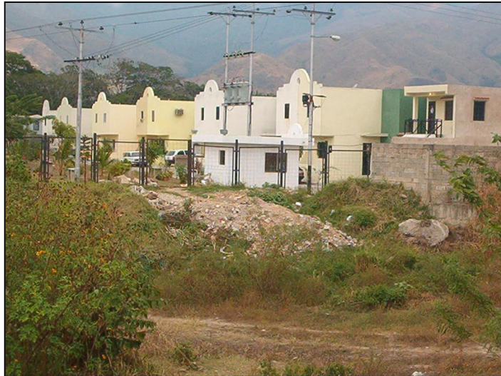
Figura 7. Vista de la planicie de la inundación sobre la margen Este del río aguas arriba del cajón hidráulico existente.
