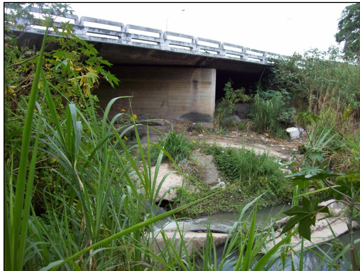
Figura 12. Vista aguas abajo del cajón hidráulico existente.
