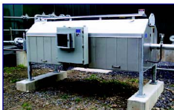
Figura 1. Calentador de gas Bruest Hot Cat.(continuación).
