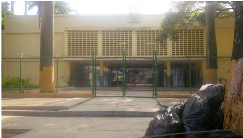
FOTO 1. Fachada de la institución.
