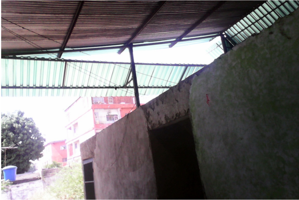
Galpón donde funcionan las aulas
