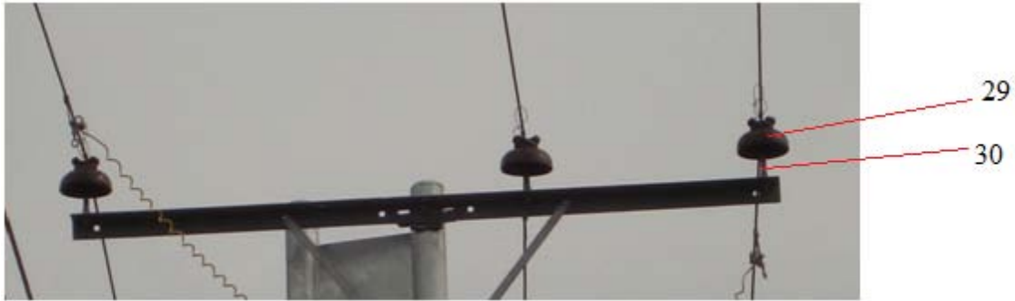
Figura 4.15 Cruceta Sencilla en Alineación
