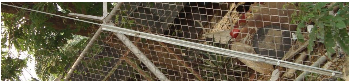
Figura 4.16 Viento para retenida de BT.
