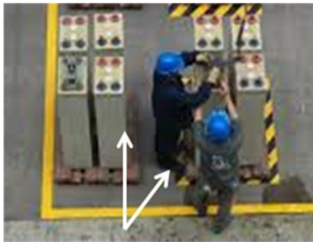
Figura No 3: Trabajo de mantenimiento a las baterías
