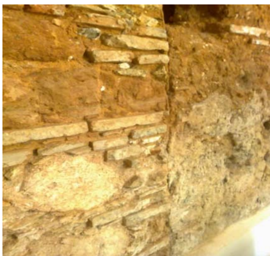
Figura 1. Muro de mampostería constituida por ladrillos de adobe. Fuente: elaboración propia
