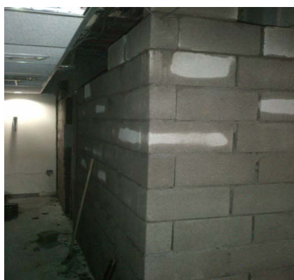
Figura 2. Trabe de Muros de mampostería no confinada. Fuente: elaboración propia
