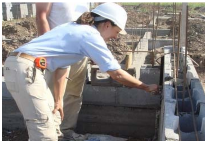
Figura 5. Construcción de Muro de mampostería reforzada. Fuente: http://www.tensolite.com.ar
