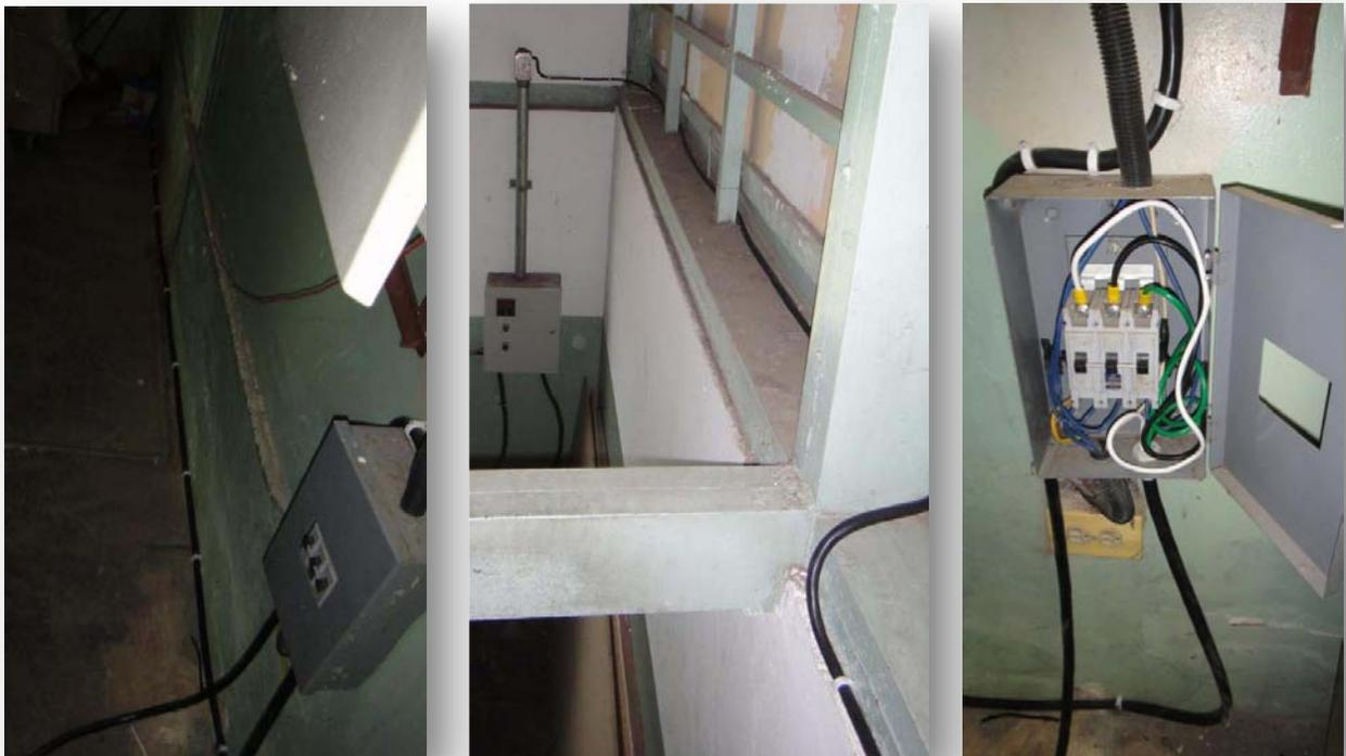
**Figura 4.1.11.** Cableado nuevo de la línea de alimentación eléctrica del equipo.
