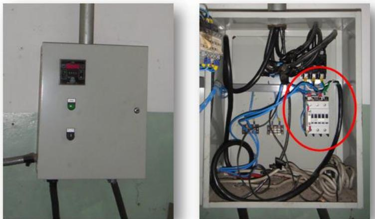
**Figura 4.1.10.** Nueva Toma Eléctrica del Equipo con señalización de las conexiones.
